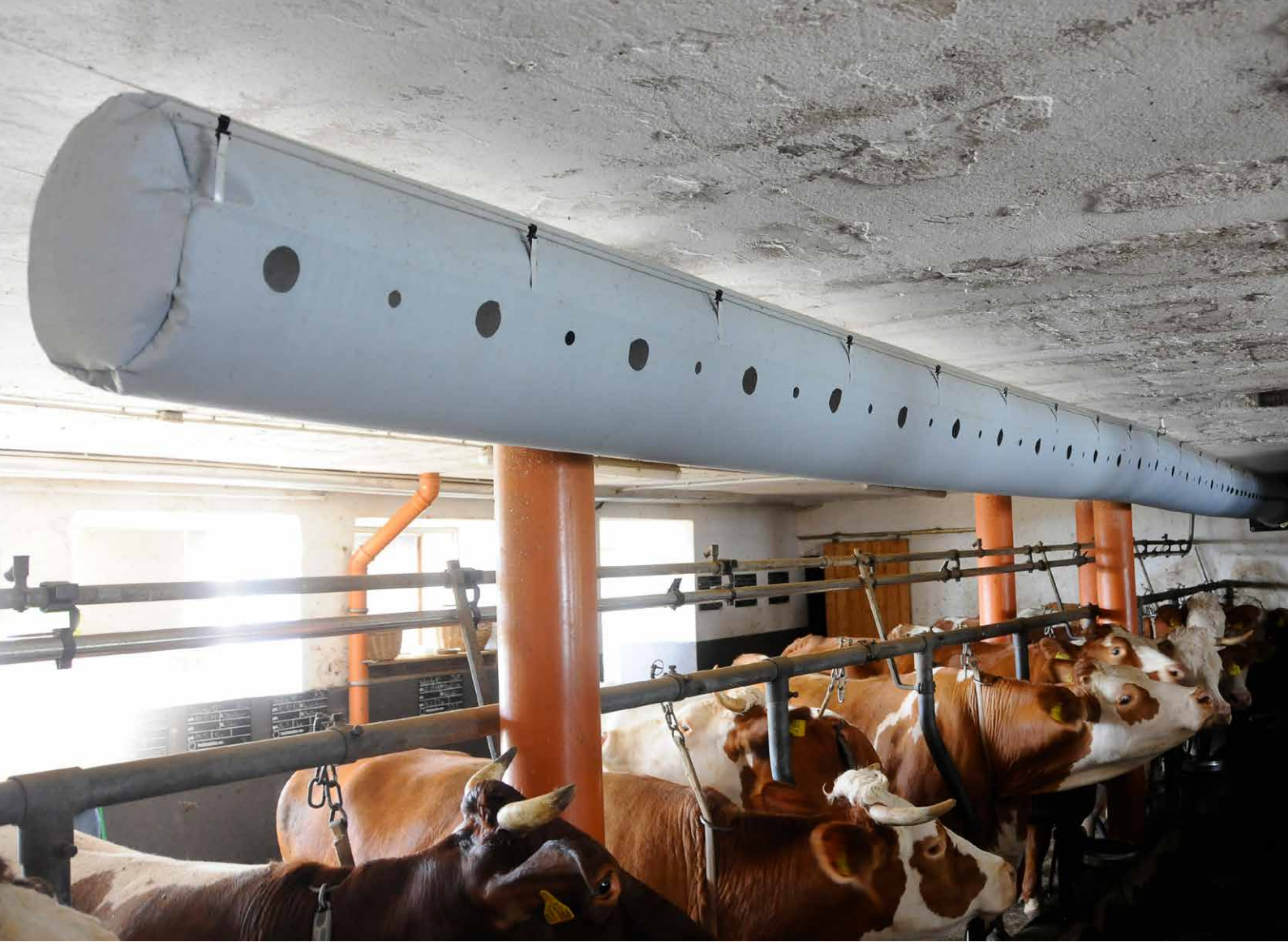
Schlauchbelüftung CAT 3000 im Kuhstall (Altbau) von Franz Baumann Schlauchlänge: ca. 10 m, Ø Schlauch: 35 cm
